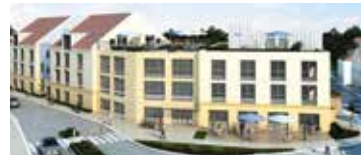
Sulzbach a. Main Im Bau Seniorenwohn- und Pflegeeinrichtung / Barrierefreies Wohnen
