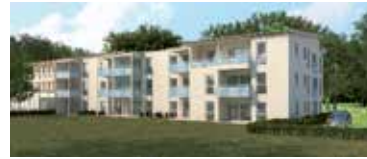
Schierling II Im Bau Barrierefreies Wohnen
