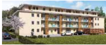
Schierling I Im Bau Barrierefreies Wohnen
