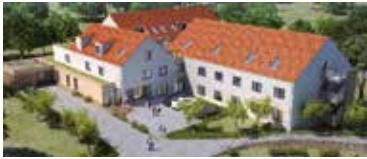
Pfaffenhofen an der Roth Im Bau Seniorenwohn- und Pflegeeinrichtung / Seniorengerechtes Wohnen
