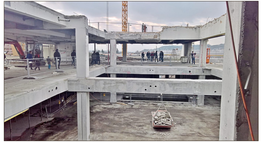
Das Dach wurde schon zu großen Teilen zurückgebaut.
