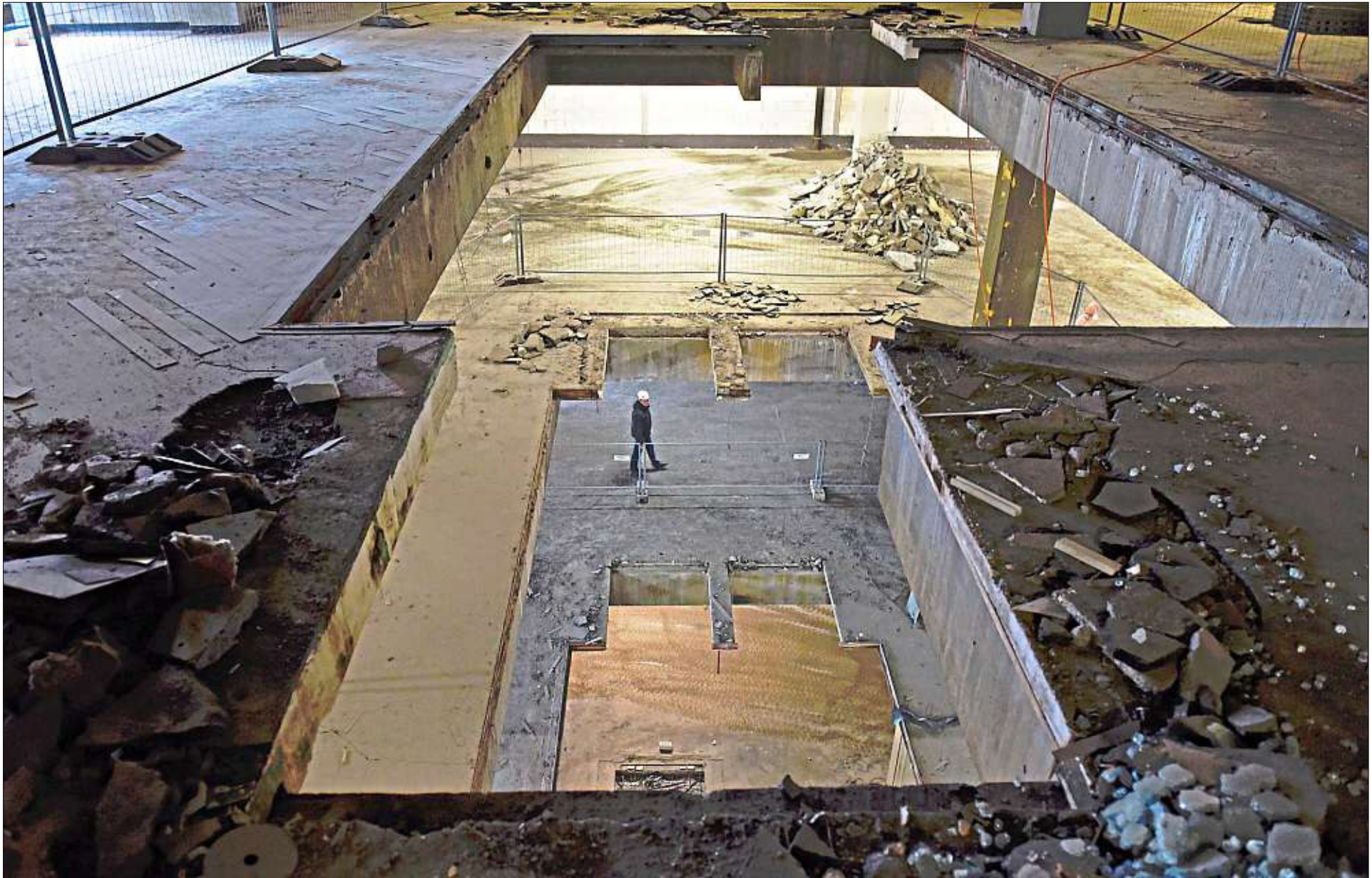
Die Rolltreppen sind weg, durch die Löcher in den Decken sieht man nun vom zweiten Stock bis in den Keller.
