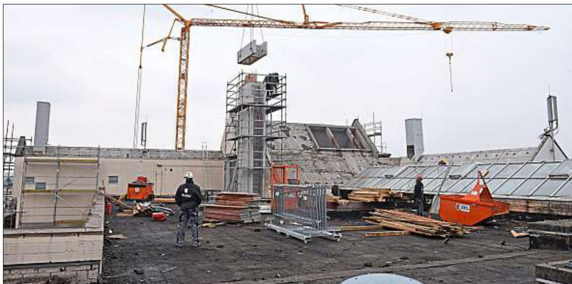
Auf dem Dach werden derzeit alle Aufbauten entfernt. Gestern war der Kamin an der Reihe. Nächste Woche wird der Teil dahinter abgebrochen, in dem die Lüftung untergebracht war.
